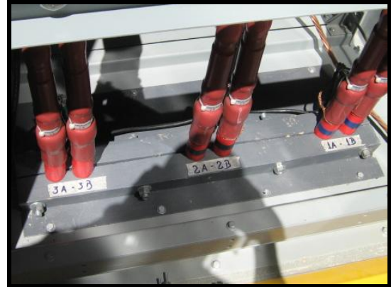
Sello en madera en conexión de celdas de 23 kv y de 3.45 kv.
