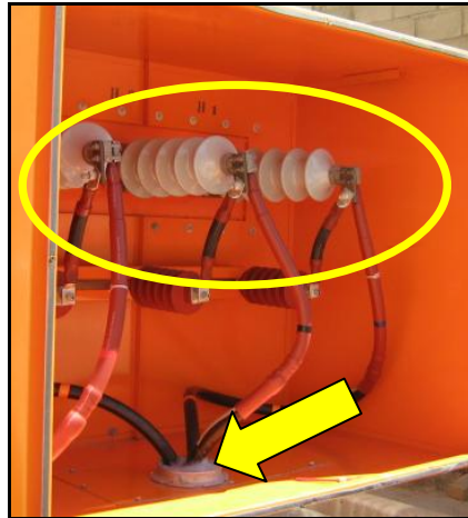
Cable con tornillos substandard (corto y oxidable) en cubículo de transformador de 5 MVA
