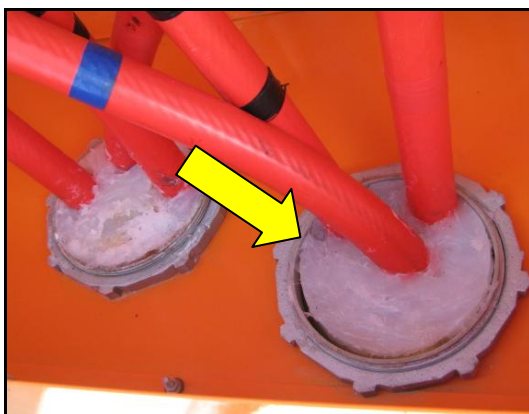
Cable de transformador 5 MVA con sello inapropiado.
